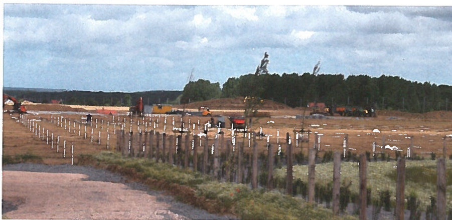
De bouw van 'Les Serres des Hauts de France' in de glastuinbouwzone van Arques is uit de startblokken.
